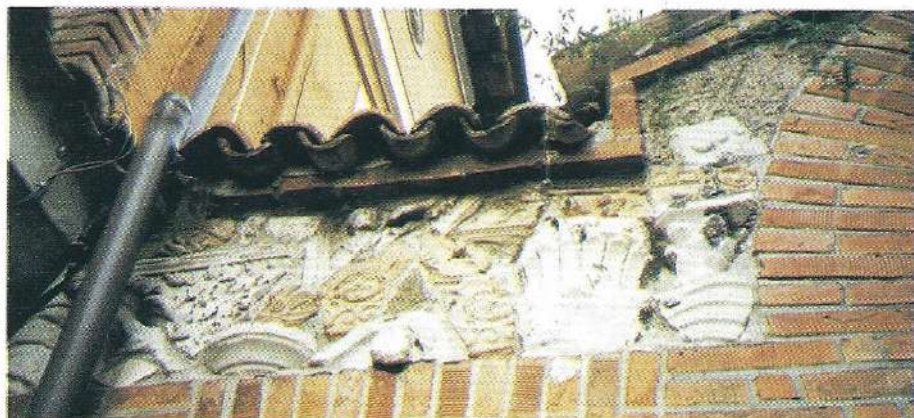
Frammenti architettonici murati in un edificio moderno a Piazza Monte Torrone
